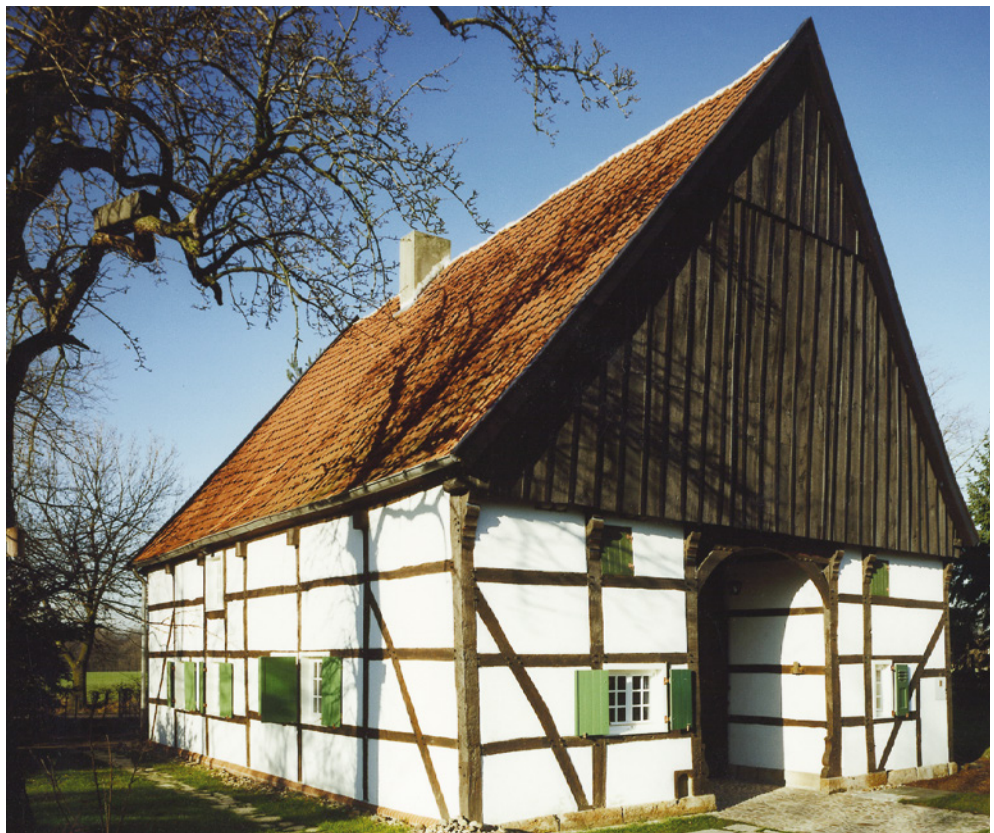
Abb. 2: Teilansicht eines westfälischen Fachwerk-Bauernhauses
